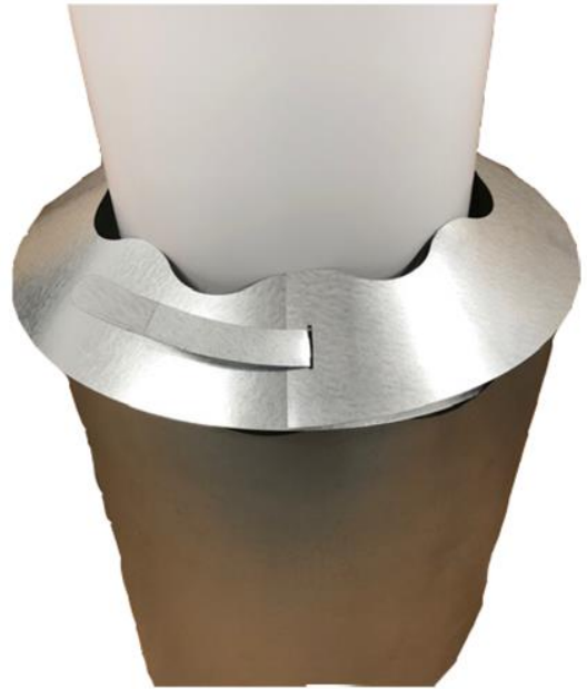
7. Viimeistele asennus suojavaipan päälle tulevalla roskasuojalla
