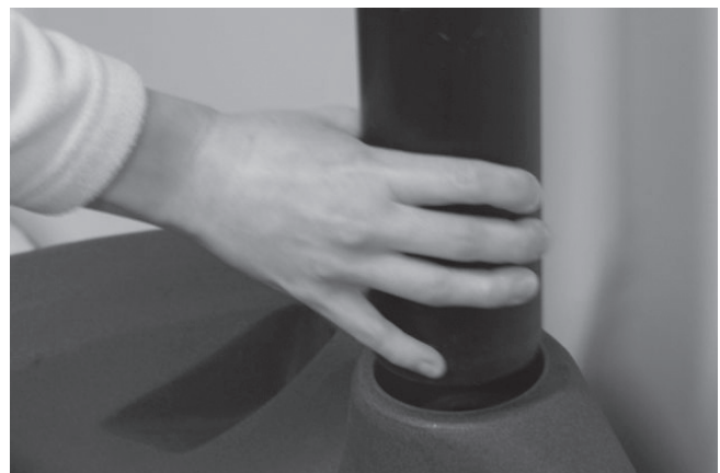
3. Lossning av ventilationsröret.
