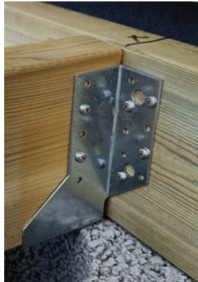
Palkkikenkä Kiinnitys 8+4 kpl 4x40 ankkurinaulaa
